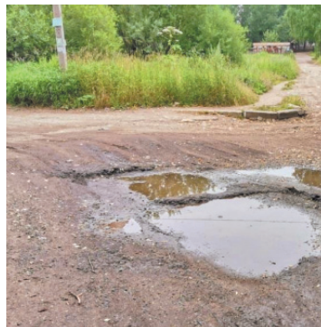
В покрытии образовалась яма
